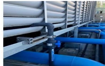
冷卻水塔 左、右各一補水點以平均補水
