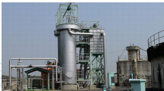
■ 圖 35 流體化床結晶處理設備圖
