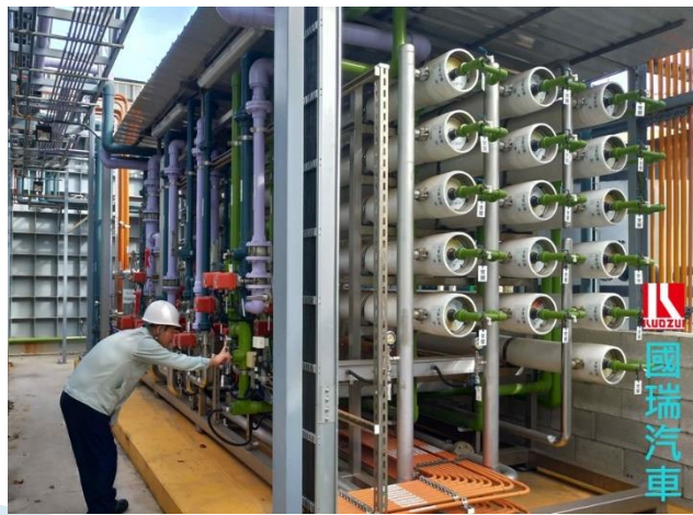
製程廢水回收: MBR、RO系統
