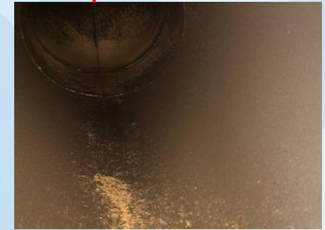
附著管壁黑色物體刮除以錳測定液測試，測試判斷為錳物質沉積。
