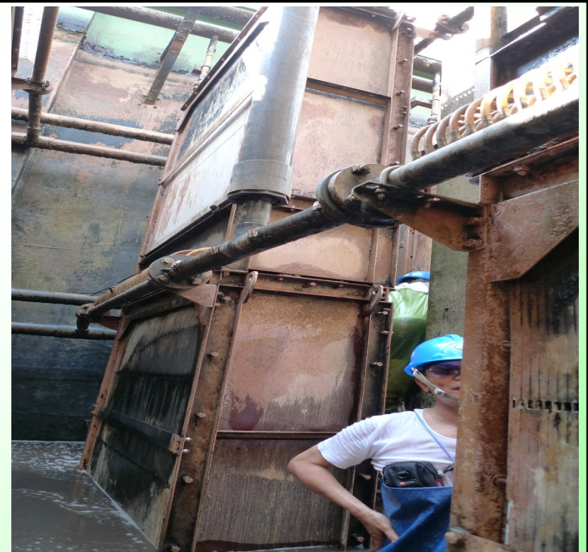
檢查MBR膜片破損情形
