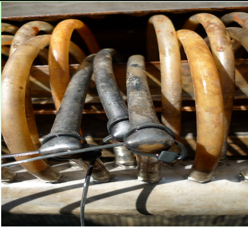
破損膜片產水管以束帶阻斷產水
