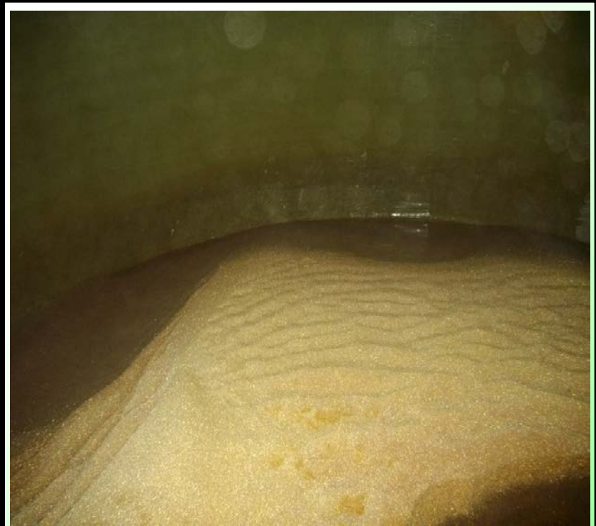
再生廢水儲槽發現樹脂流失
