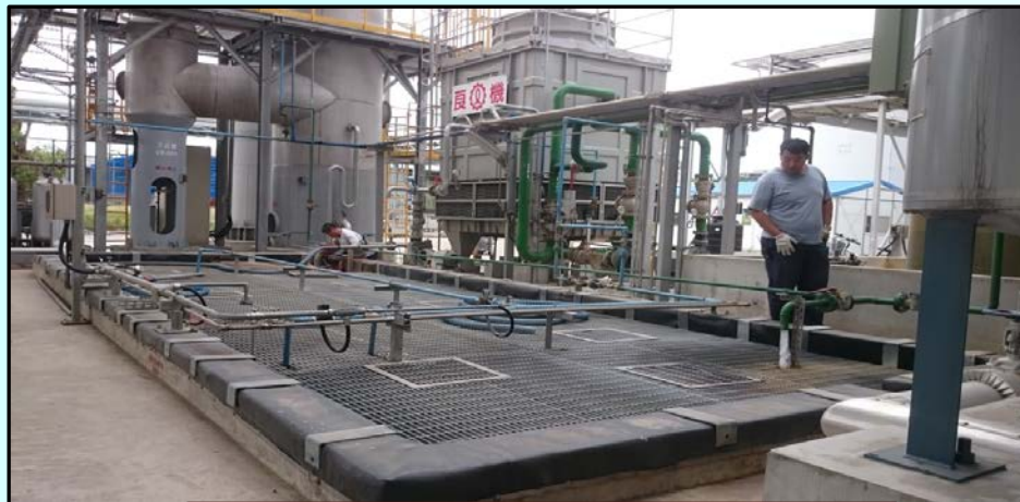
放流水回收系統-循環水槽
