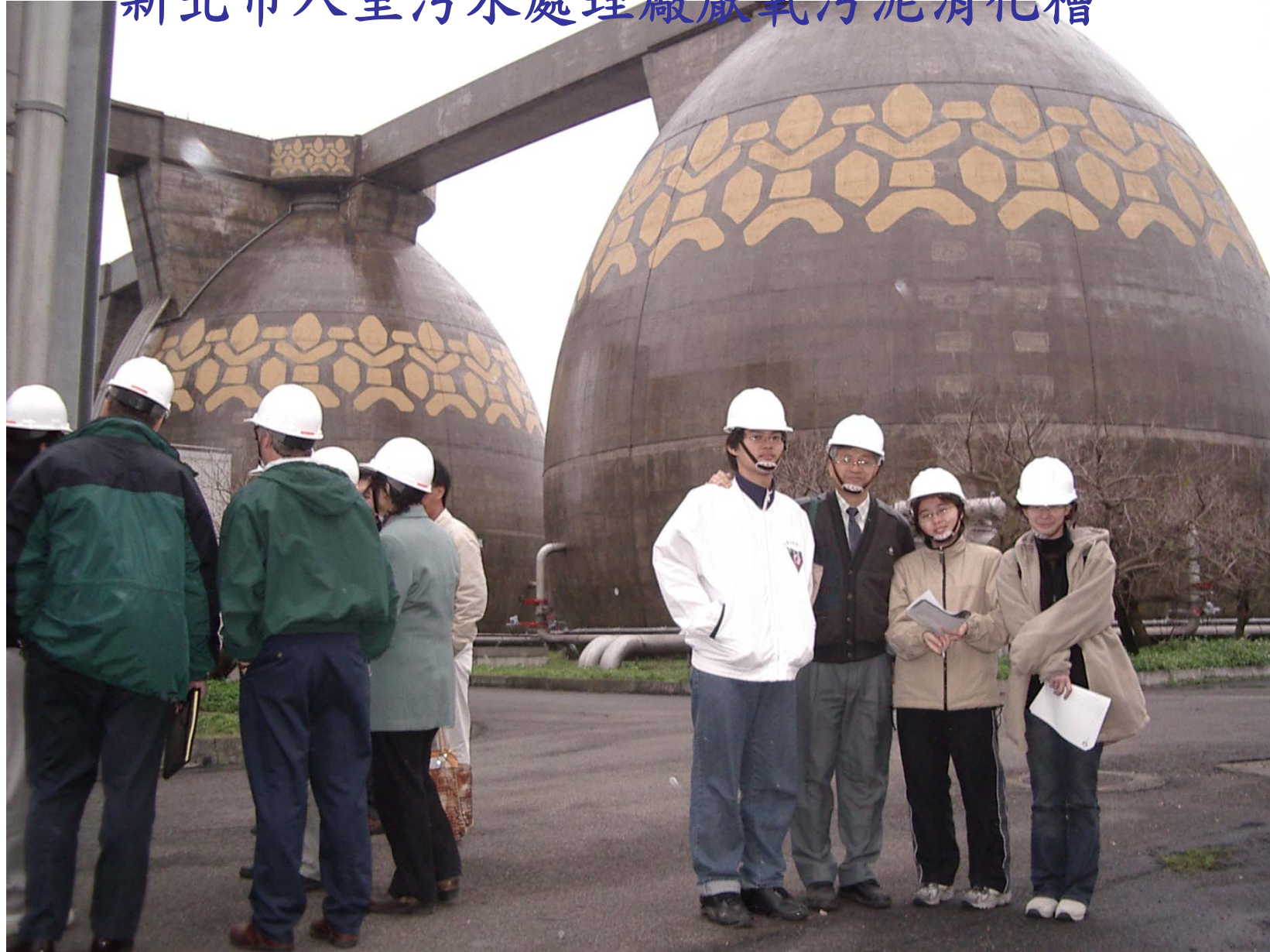
照片 八里污水處理廠蛋型厭氧污泥消化槽 (9,900m 3 ×6槽) 2005.01.20
