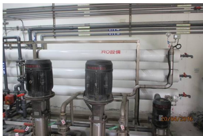
圖 27 奈米過濾系統設備圖
