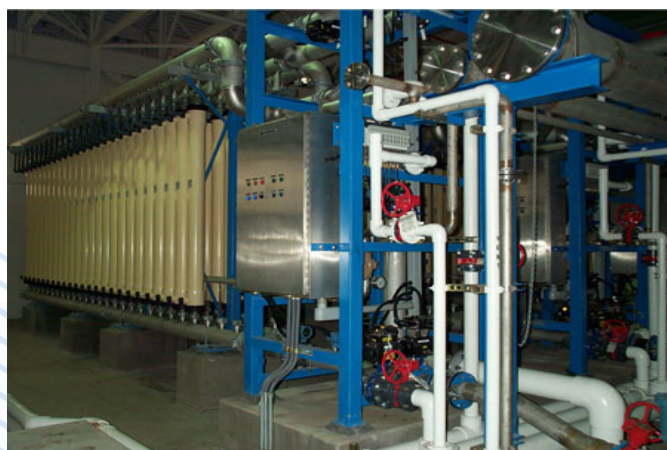
圖 26 超過濾系統設備圖
