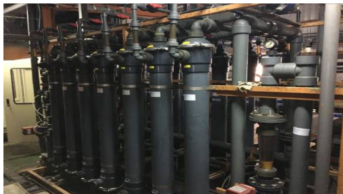
圖 25 微過濾系統設備圖
