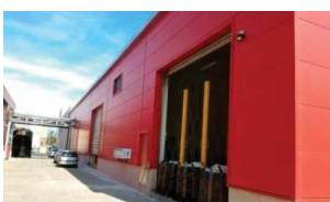
中美矽晶宜蘭廠廢水處理
