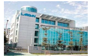
大立光電冷卻排水回收
