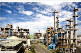
長春石化彰濱廠廢水處理
