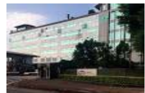
達信科技平鎮與南科廠 廢水處理與回收
