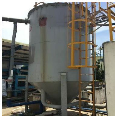
圖 14 砂濾處理系統設備圖
