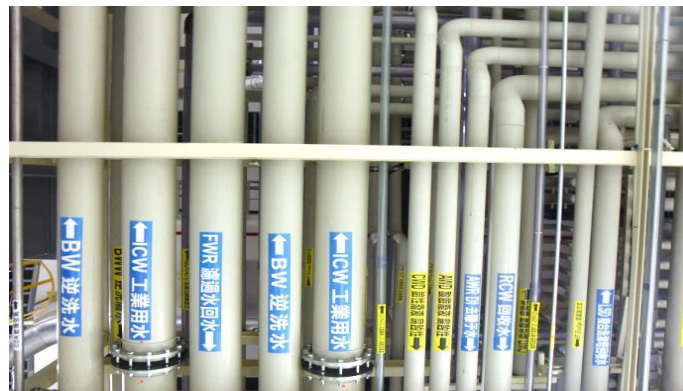
製程廢水分流收集管線
