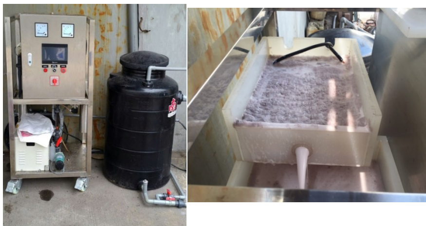
圖 31 電混凝處理系統設備圖
