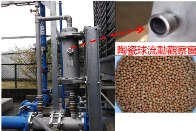
圖 19 陶瓷球水處理設備圖
