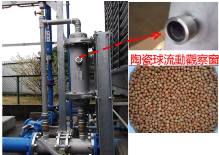
圖 16 陶瓷球水處理設備圖
