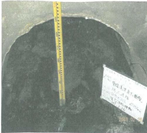
圖 3-7 SF19~SF18 管段(油脂塊阻塞嚴重)
