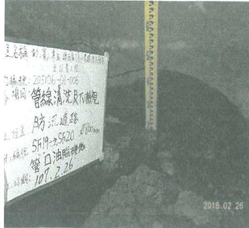
圖 3-8 SF19~SF20 管段(油脂塊阻塞嚴重)
