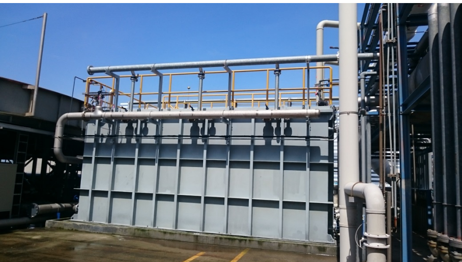
MBR有機生物排水處理系統
