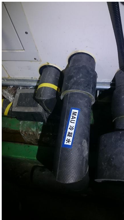
空調箱冷凝水回收管路
