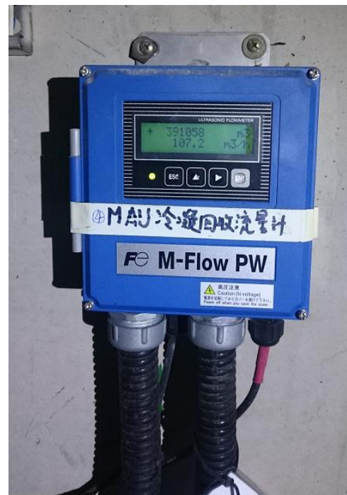
冷凝水回收流量計
